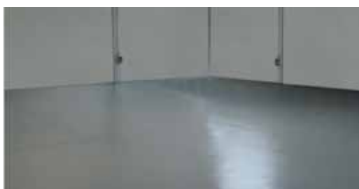
PISO COM REVESTIMENTO CONDUTIVO EPÓXI CINZA CLARO
